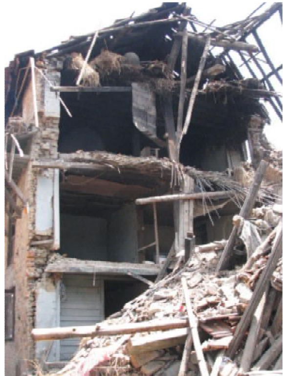
Figure 45. End wall collapse, Bungamati.
