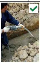
应使用振捣棒振捣,帮助 混凝土流到毛石之间的缝 隙里去。
