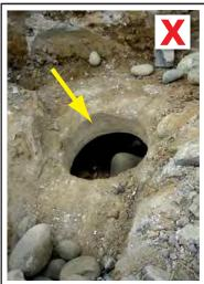
旧址重建时, 若挖出旧基础, 土,大树根,井或沼气池等应妥 善处理,否则会引起新的地基沉 降。应该先把它们清理掉,再用 小颗粒细石混凝土回填。
