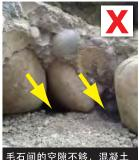
毛石间的空隙不够,混凝土 无法注满。
