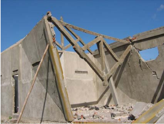
Gambar 26. Rumah/toko dengan kuda kuda beton, Bebekan Mulyodadi, Bambang Lipuro (Bantul) S7.93460° E110.32194°, IMG_6778
