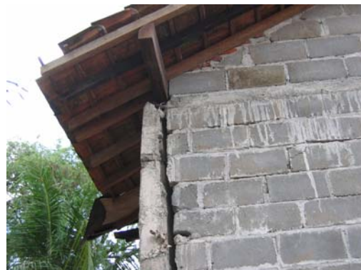
Gambar 16. Sambungan yang tidak cukup antara kolom dengan ring balok, Segoroyoso, Pleret (Bantul) S7.88174° E100.40869°, IMG_6749
