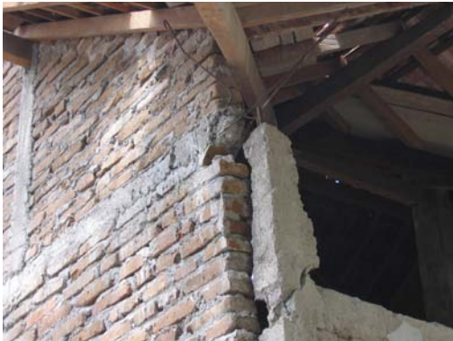
Gambar 17. Sambungan yang tidak cukup antara kolom dengan ring balok, Pleret (Bantul) S7.88174° E100.40869°, IMG_6746
