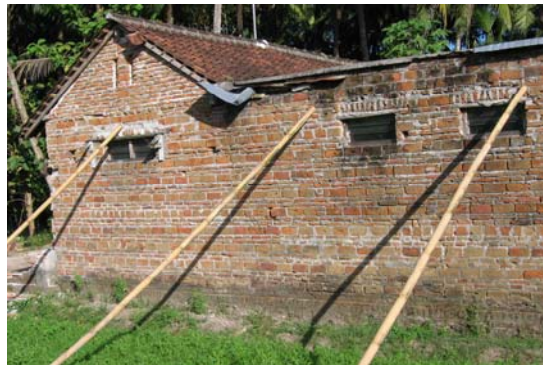
Gambar 7. Pasangan bata tanpa tulangan, Bebekan Mulyodadi, Bambang Lipuro (Bantul). S7.94160°, E110.32297° IMG_6806
