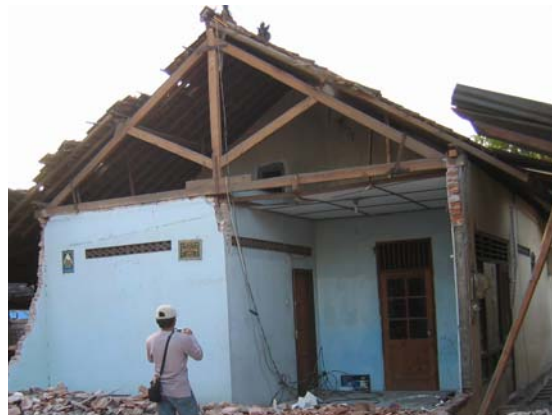
Gambar 25. Kuda kuda kayu yang umum dipakai dengan plat baja untuk memperkuat sambungan, Kasongan, Kasihan (Bantul), S7.84512° E110.33534° IMG_6831.
