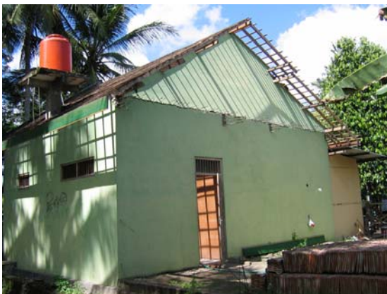
Gambar 18. Tombak layar dari pasangan bata yang terjungkir, Keputren, Pleret (Bantul) S7.86905° E110.40272°, IMG_6721
