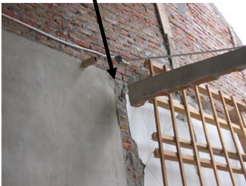
Gambar 15. Tampilan diperbesar dari ring balok tanpa sambungan, IMG_6579
