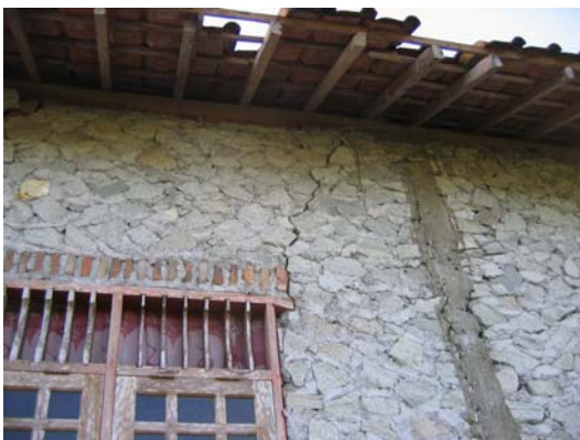
Gambar 10. Rumah setengah ikatan batu dengan ring balok dari kayu, Platar Somopuro, Jokonalan (Klaten), S7.75478, E110.53557, IMG_6897
