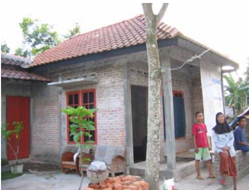
Gambar 8. Rumah ikatan bata yang dirancang dan dibangun dengan baik, di ujung daerah yang mengalami kerusakan sangat parah di Pleret (Bantul), S7.83686° E110.41552°, IMG_6636
