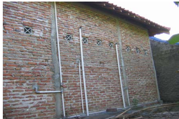
Gambar 9. Sisi belakang dari rumah ikatan bata yang dirancang dan dibangun dengan baik, Bebekan Mulyodadi, Bambang Lipuro (Bantul), S7.94160°, E110.32297°, IMG_6804
