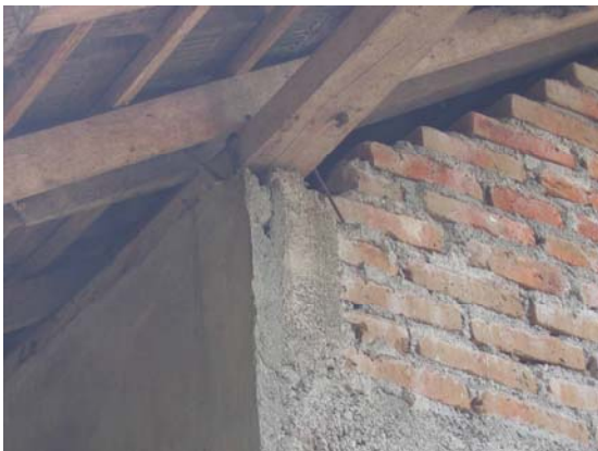
Gambar 24. Sambungan yang umum dijumpai di antara kolom dan ring balok – besi tulangan kolom dilingkarkan pada kayu, Jejeran-1, Wonokromo, Pleret (Bantul), S7.86480° E110.38821° IMG_6672.
