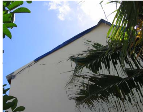
Gambar 12. Keretakan pada tombak layar yang terbuat dari pasangan bata, rumah CEEDEDS, Jejeran-2, Wonokromo, Pleret (Bantul), S7.86676° E110.38764°, IMG_6696
