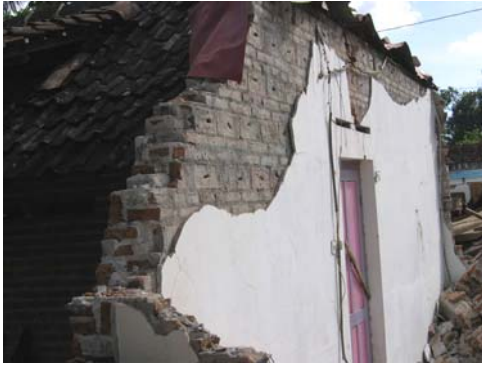
Gambar 6. Pasangan bata tanpa tulangan. Sumbemilo (Bantul) IMG_6771
