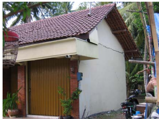
Gambar 19. Tombak layar dari pasangan bata yang terjungkir (Bantul) S7.89468°, E110.37341°, IMG_6542
