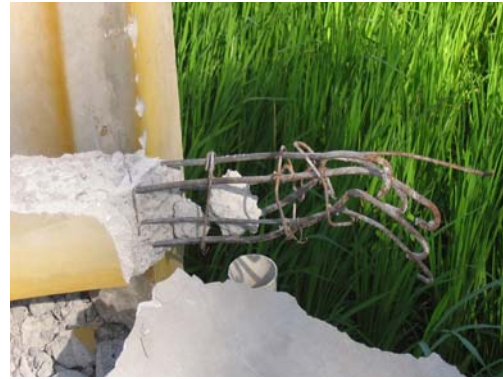
Gambar 27. Tulangan pada ring balok untuk rumah/toko, Bebekan Mulyodadi, Bambang Lipuro (Bantul) S7.93460° E110.32194°, IMG_6781
