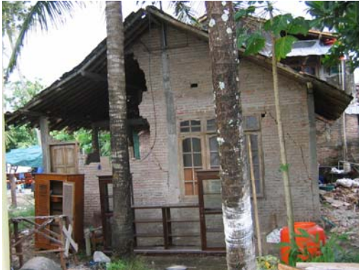
Gambar 22. Dinding pasangan bata yang runtuh (perhatikan tidak adanya ring balok), Pleret (Bantul) IMG_6589
