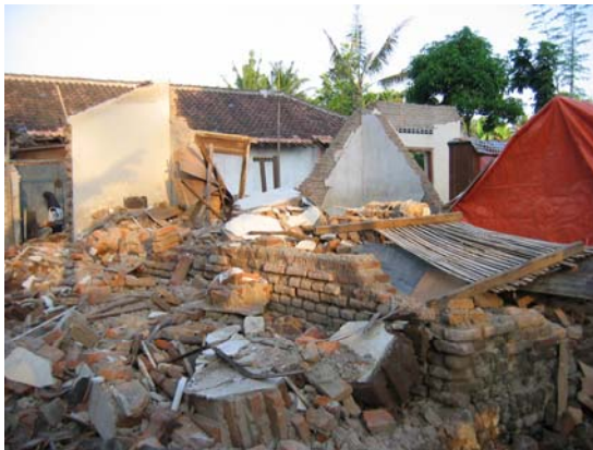
Gambar 4. Rumah-rumah berstruktur pasangan bata tanpa tulangan yang hancur, Pleret (Bantul), S7.83686° E110.41552° IMG_6633
