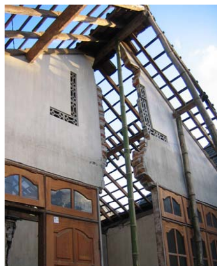
Gambar 21 Tombak layar (offset gable) yang runtuh, Kasongan, Kasihan (Bantul), S7.84512° E110.33534°, IMG_6824
