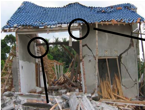
Gambar 13. Rumah ikatan bata yang sedang dibangun, sambungannya tidak cukup, Pleret (Bantul). S7.87574°, E110.40703°, IMG_6575
